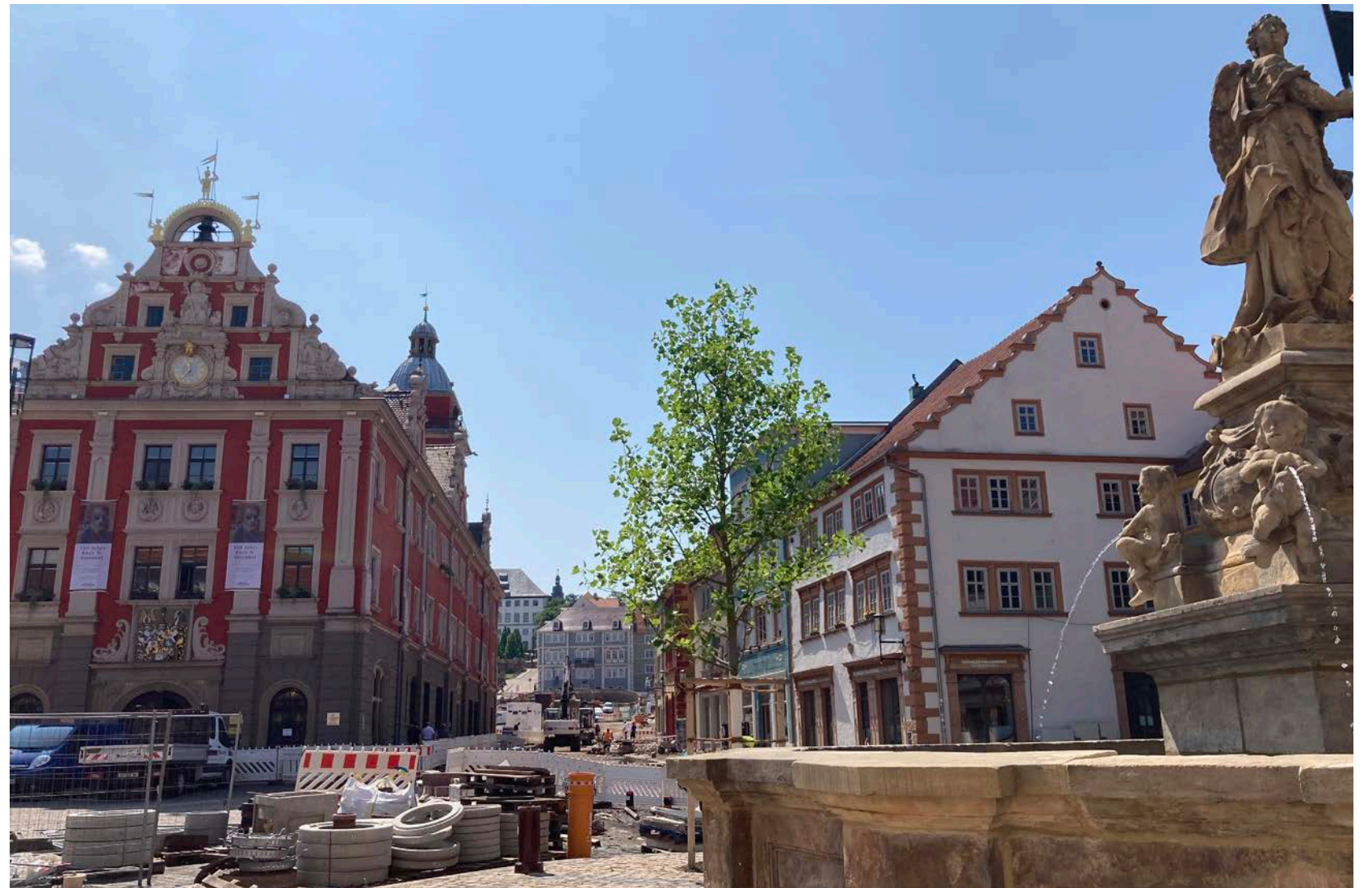
Der Hauptmarkt von Gotha wird umgestaltet. Die ProjektStadt der NHW begleitet den Prozess und berät – von Denkmalschutz bis Klimawandel © NHW ProjektStadt
